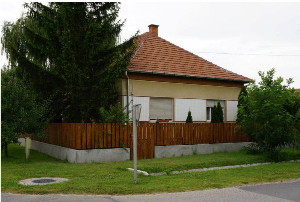
Jellegzetes épülettípusok: 1960-as években épült sátortetős lakóház
